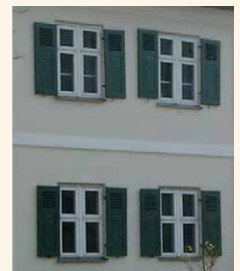
Fenster mit Klappläden – historische Form
