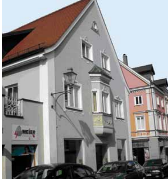
Fassade giebelständig axial
