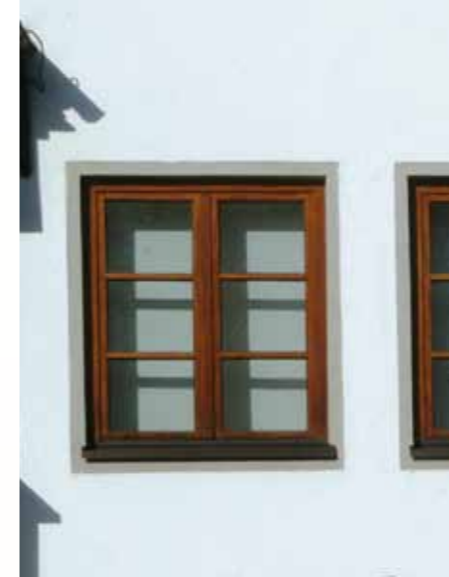
Fenster unterschiedlicher Form und Teilung
