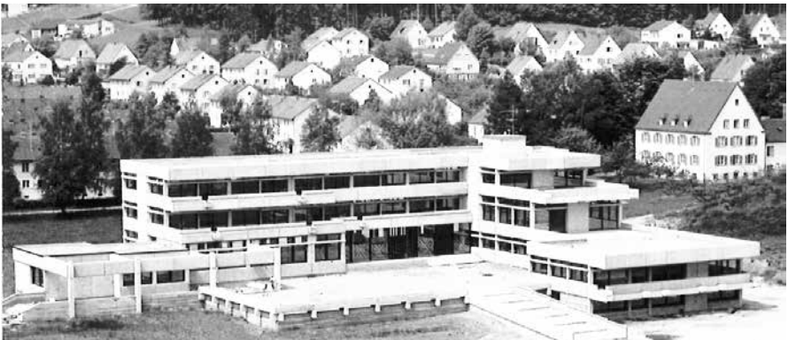
Das Ämtergebäude kurz vor der Fertigstellung im Herbst 1971, wobei damals schon feststand, dass es als Landratsamt nicht mehr gebraucht wird.
