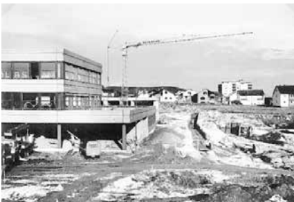
Das Schulzentrum in der Bauphase. Das Bild entstand im Jahr 1977.
